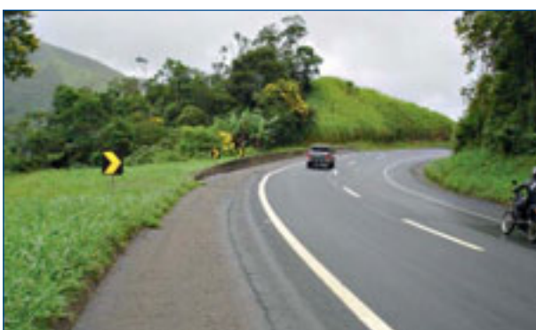
Foto 4 – km 514+400 – Início da curva nº 3 de raio restrito onde ocorrem grande parte dos acidentes
