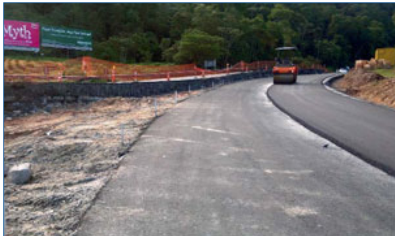
Figura 15 – Obras de recuperação no km 101
