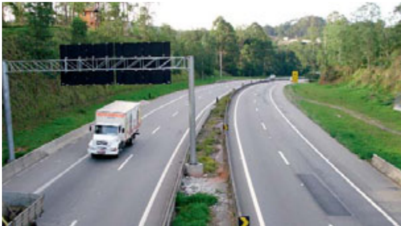
Foto 1 – Visão geral – sinalização horizontal
