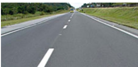
Fig. 07 – Segmento reciclado com capa de rolamento de microrrevestimento
