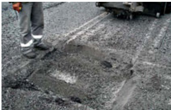
Fig. 01 – Camada de rolamento antes da intervenção
