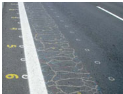
Fig. 13 – Área de atuação com monitoramento
