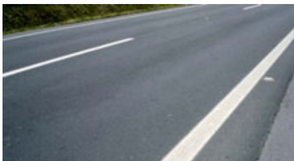
Fig. 06 – Segmento reciclado com capa de rolamento de CBUQ
