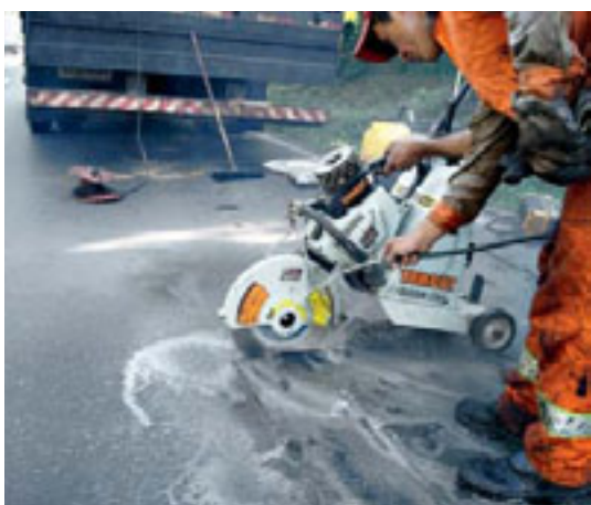
Figura 1 – Corte das placas na pista-teste
