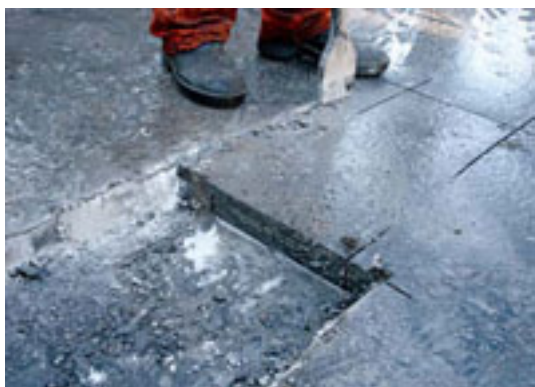
Figura 2 – Remoção com martelete das placas
