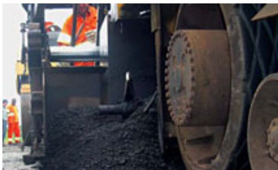
Fig. 04 – Mistura reciclada a frio
